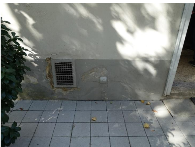
Abbildung: Hausfasade Innenhof
