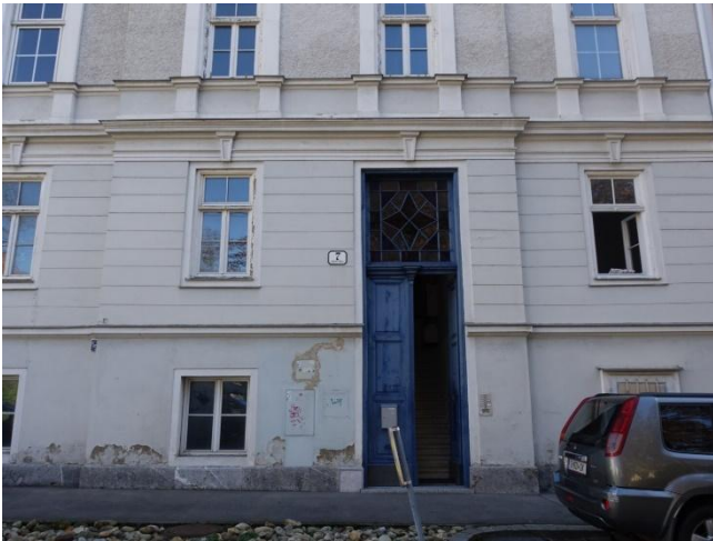
Abbildung: Zugang zur Liegenschaft
