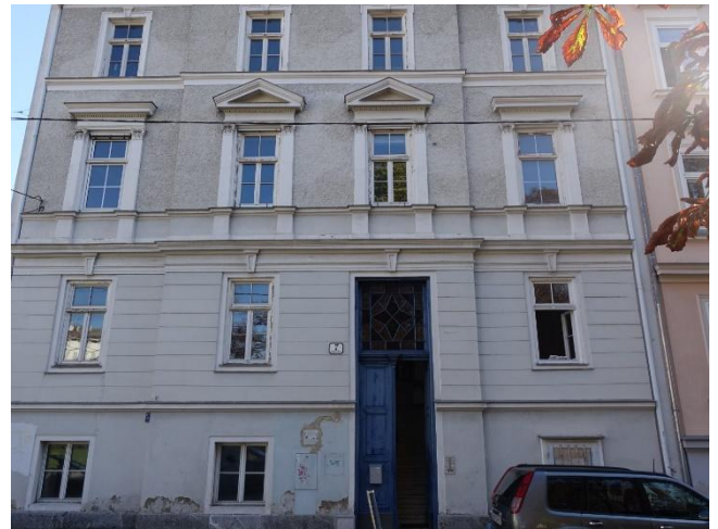
Abbildung: Blick auf die Liegenschaft, EZ 828 (Zinshaus)
